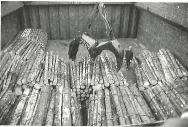
*Vue depuis le poste de conduite d'une grue du Port Autonome de Rouen : déchargement de grumes situées dans la cale d'un navire.*
